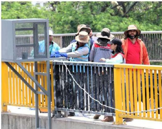
Los equipos de la Alcaldía capitalina instalaron un medidor electrónico del nivel de agua del río Choluteca, que permitirá advertir en tiempo real sobre posibles inundaciones en zonas vulnerables ubicadas en los márgenes del afluente.
