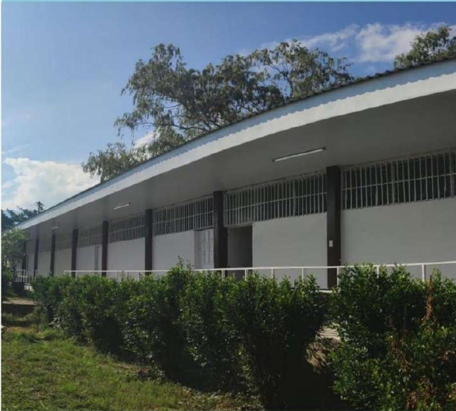
Entre las mejoras efectuadas está el resane de paredes, instalación de aislante térmico, cambio de la estructura del techo con su lámina de aluzinc, mejora de la pintura, de las instalaciones eléctricas, instalación de cielo falso, pintado de puertas, ventanas y balcones, mejora de cinco aulas y un laboratorio de ciencias naturales.
